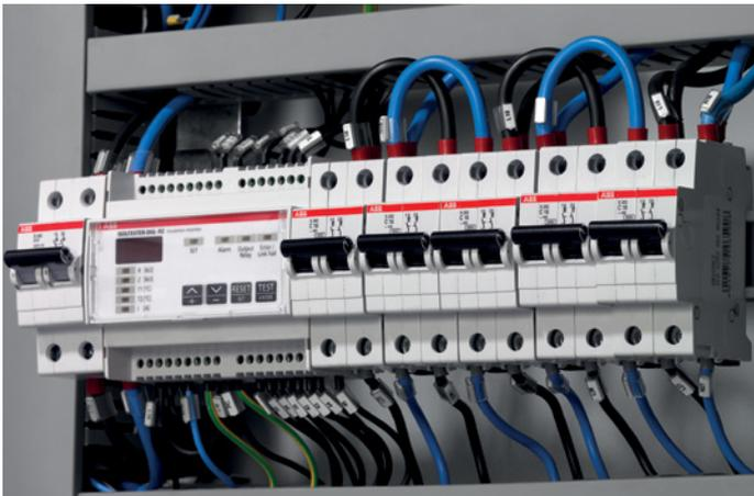
Это устройство контроля изоляции для медицинских учреждений группы 2 полностью совместимо со стандартом IEC 60364-7-710. Оно отвечает всем рабочим характеристикам, установленным стандартом, например, контролю перегрузки и сверхтоков в сочетании с традиционными измерениями изоляции системы заземления ИТ.
