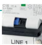
Отображает причину срабатывания выключателя дифференциального тока DS200. Синий (срабатывание из-за дифференциального тока) или черный (срабатывание по сверхтоку).
